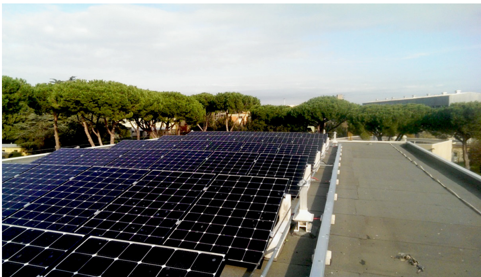
Fig. 2 – L'impianto fotovoltaico dello smart Building
